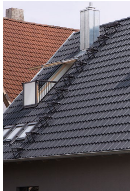
Nosná taška s držákem stoupací plošin Funkce: 4800
